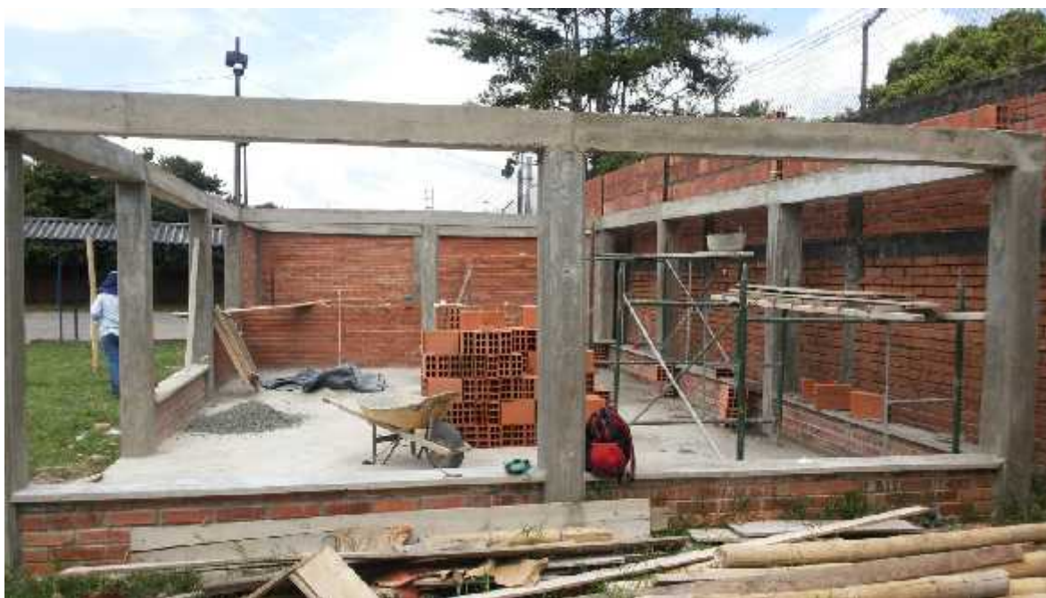
Foto No 4: Estado de la construcción en las primeras visitas realizadas por el organismo fiscal
